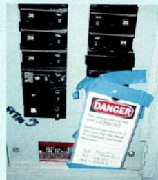
Cadenassage non-conforme
